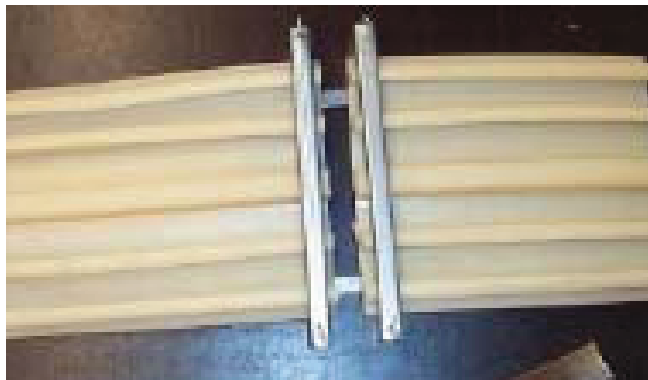
I. Fugenband einlegen. Insert waterstop ends.
