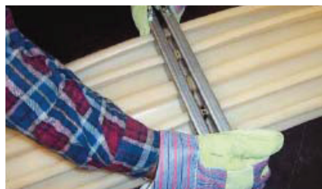
III. Schweißschwert zwischen den Profilenden einsetzen und andrücken bis sich eine Wulst von ca. 5 mm Durchmesser gebildet hat. Anschließend ist das Schweißschwert herauszuziehen. Insert hot blade and push waterstop ends against blade. Maintain contact until plastic melds into bead of about 5 mm diameter. Remove knife.
